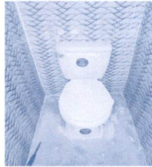
Foto 10. Sustitución de inodoro
