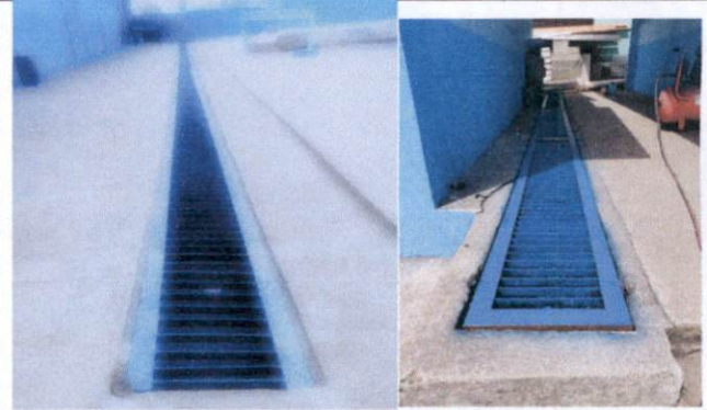
Foto 8. Cambio de regias en mal estado por nuevas
