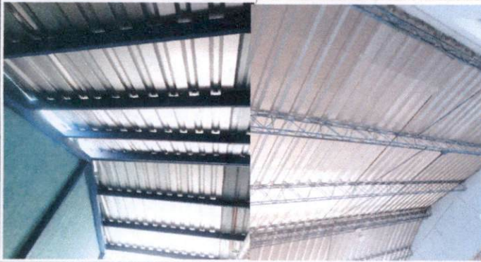
Foto 1. Sustitución de lámina, sustitución de soporte de madera por metal
