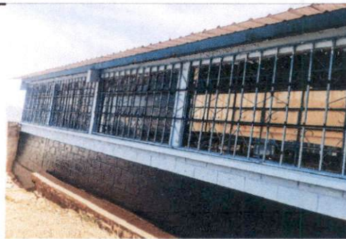
Foto 6. Sustitución de vidrios
