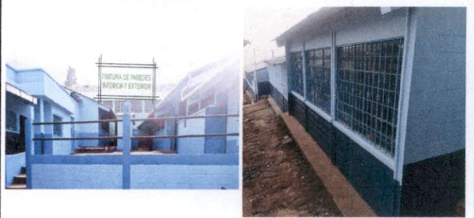
Foto 4. Pintura de muros exteriores e interiores
