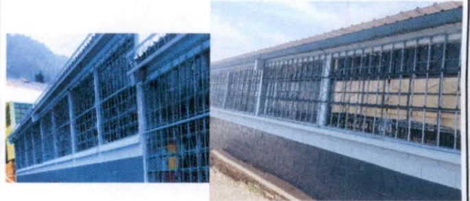
Foto 2. Mantenimiento a balcones
