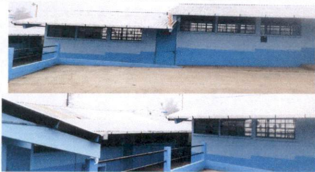
Foto 5. Cambio de tuvos por canales blancos y bajadas de agua
