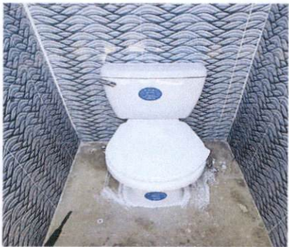
Foto 3. Sustitución de accesorios de sanitarios
